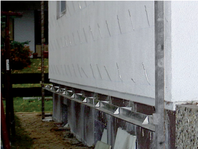
Fundamentkonsolen ab Oberkante Sockel
