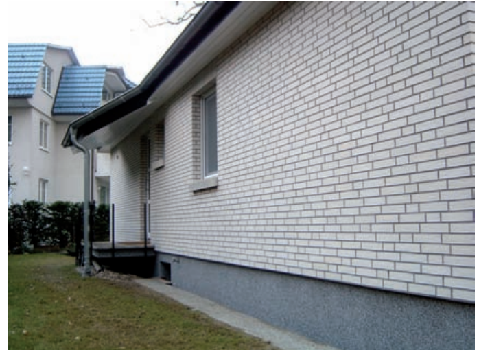
Verklinkerung ab Oberkante Sockel (Sockel in Buntsteinputz)
